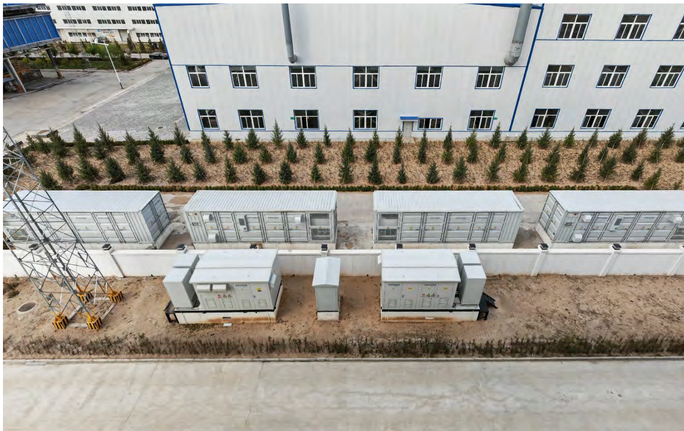
陕西陕煤集团曹家滩矿井备电项目
