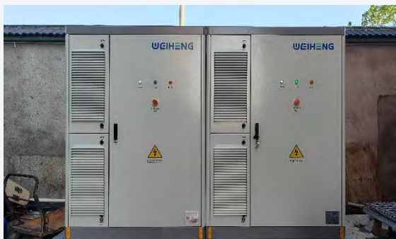
浙江华诚模具 储能项目
