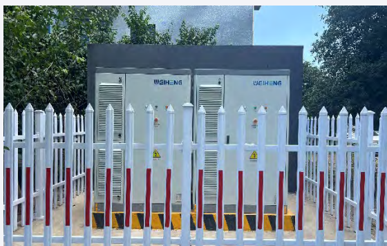
浙江新磊混凝土 储能项目
